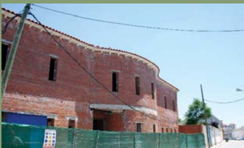
Obras del CAI y de la Escuela de Música y Danza.
